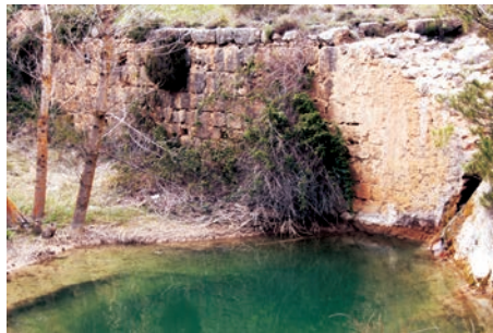
Antigua presa sobre el río Barbata
